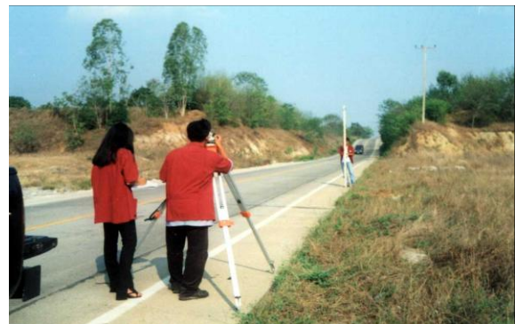
รูปที่ 4 การสำรวจเพื่อใช้ในการออกแบบท่อส่งน้ำดิบ
