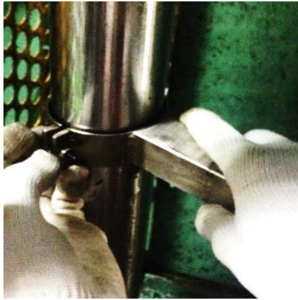
รูปที่ 8 การติดตั้งอุปกรณ์กำหนดตำแหน่งเข้ากับเครื่องจักร
