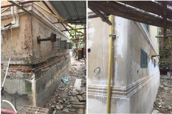
ก) อาคารด้านหน้าหลังจากการยก ข) ขั้นตอนการเก็บผิวอาคาร ปรับระดับความสูงอาคาร
