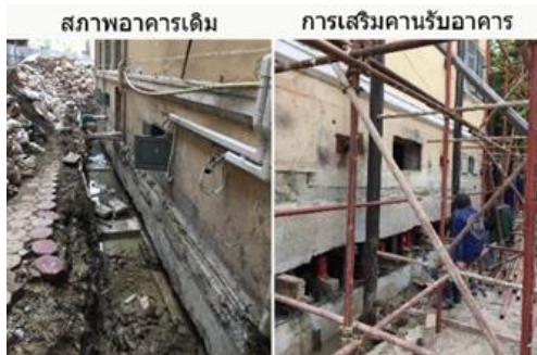
ข) การขุดหาระดับฐานอาคาร เพื่อเตรียมเสริมคานและสร้างฐานรากอาคารด้วยเสาเข็มเหล็ก ค) การเสริมคานคอนกรีต 2 ระดับและทำการปรับระดับความสูงอาคารด้วยปั๊มแม่แรง
