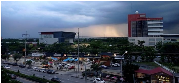
รูปที่ 6 เรโดมสายอากาศ 2.4 เมตร ย่านความถี่ X/L ติดตั้งบนอาคาร D ของมหาวิทยาลัยเทคโนโลยีมหานคร
