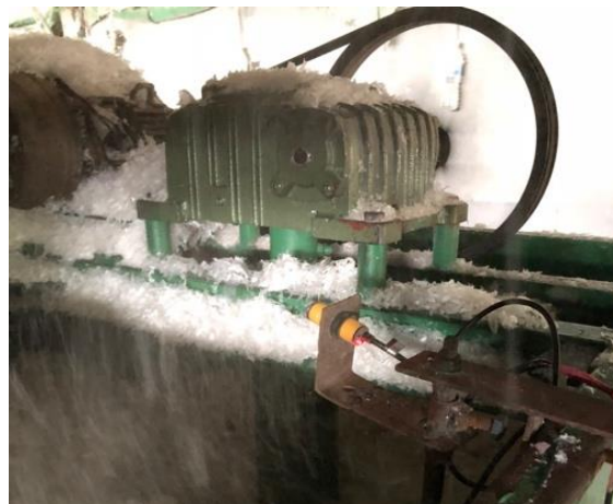
ภาพที่ 8 ตำแหน่ง Sensor ในการติดตั้งที่ Hopper
