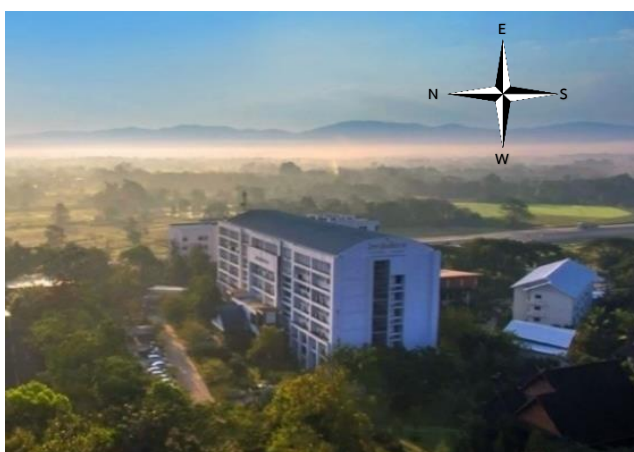
ภาพที่ 2 อาคารเฉลิมพระเกียรติ วิทยาลัยเชียงราย ที่ศึกษาติดตั้งระบบเซลล์แสงอาทิตย์
