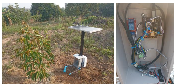
ภาพที่ 4 Hardware of system
