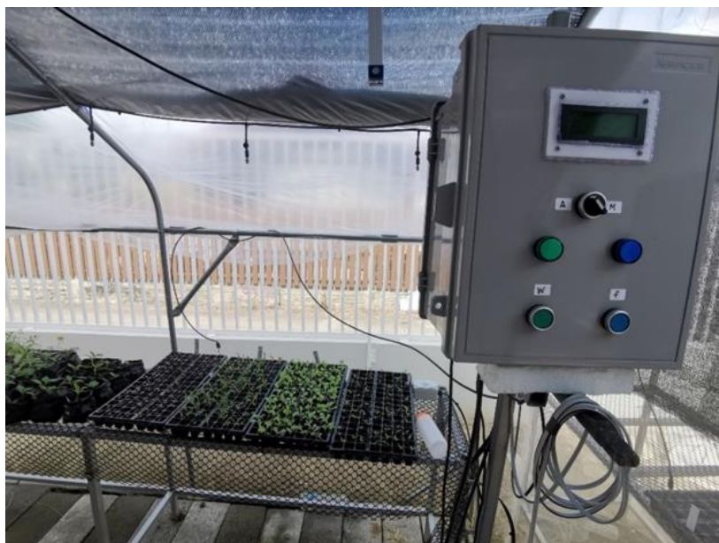
ภาพที่ 3 การติดตั้งกล่องควบคุมในโรงเรือนอัจฉริยะ
