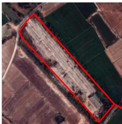
พื้นที่สถานที่กำจัดขยะมูลฝอย
