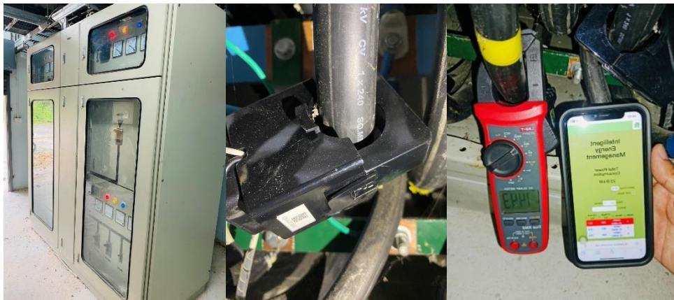
รูปที่ 1 การเก็บรวบรวมข้อมูลการใช้พลังงานใช้เซ็นเซอร์วัดกระแสไฟฟ้าร่วมกับระบบ IoT
