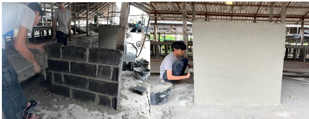
รูปที่ 7 ก่อคอนกรีตบล็อกและทำการฉาบผนังเพื่อใช้ในการทดสอบ
