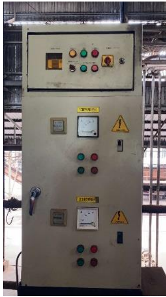
ก่อนการติดตั้งอินเวอร์เตอร์
