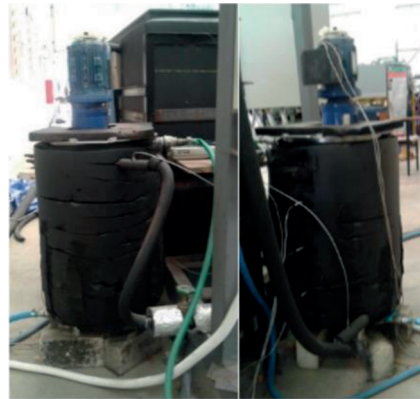
ข) การติดตั้งมอเตอร์ใบกวนกับถังน้ำร้อน รูปที่ 14 มอเตอร์ตีดใบกวนบนถังน้ำร้อน
