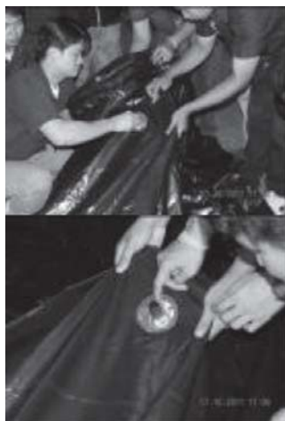
รูปที่ 5 แสดงการติดชุดส่งแก๊ส
