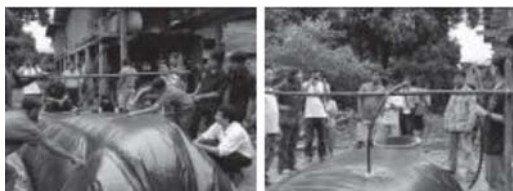
รูปที่ 11 แสดงการประกอบสายส่งแก๊ส พร้อมทั้งติดตั้งขวดปรับแรงดันและดักน้ำ
