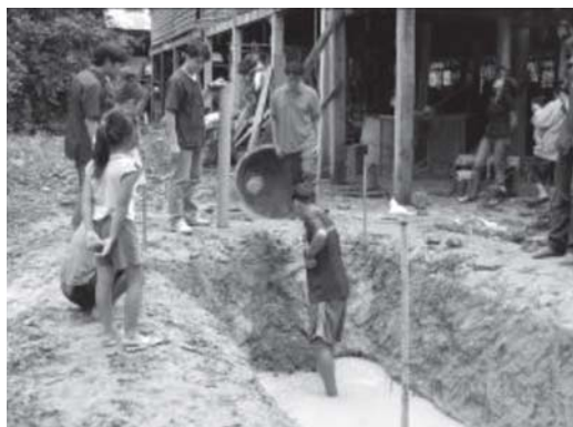
รูปที่ 8 แสดงการทำรางสำหรับวางท่อทางเข้าของมูลและบ่อน้ำ
