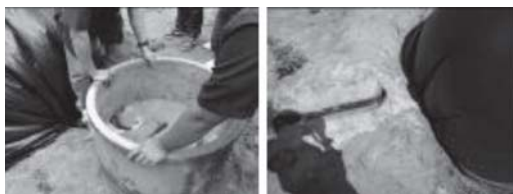
รูปที่ 10 แสดงการทำบ่อทางเข้าของมูลและบ่อน้ำทางออก
