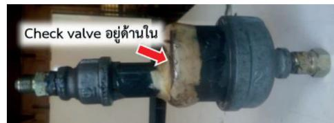
รูปที่ 6 Check Valve Assembly
