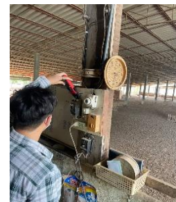
รูปที่ 3 การตรวจวัดการใช้พลังงานไฟฟ้าของอุปกรณ์ในระบบต่างๆ ในฟาร์มเป็ดไข่
