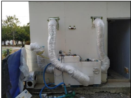
รูปที่ 11 การติดตั้งเครื่องทำความเย็นแบบน้ำระเหย
