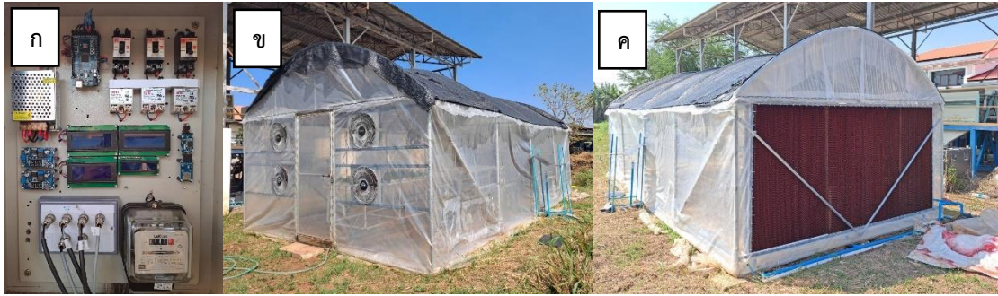
รูปที่ 1 ก) ตู้ควบคุมควบคุมโรงเรือน ข) ด้านหน้าโรงเรือน ค) ด้านหลังโรงเรือน
