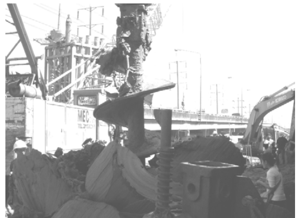
รูปที่ 3 การเจาะและเก็บตัวอย่างดิน ณ สถานที่ก่อสร้าง
