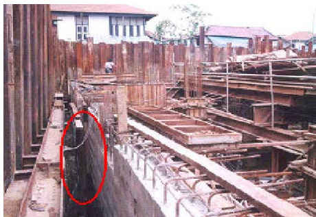
รูปที่ 1. แสดงการถอดค้ำยันออกก่อนที่จะถมทราย [3]
