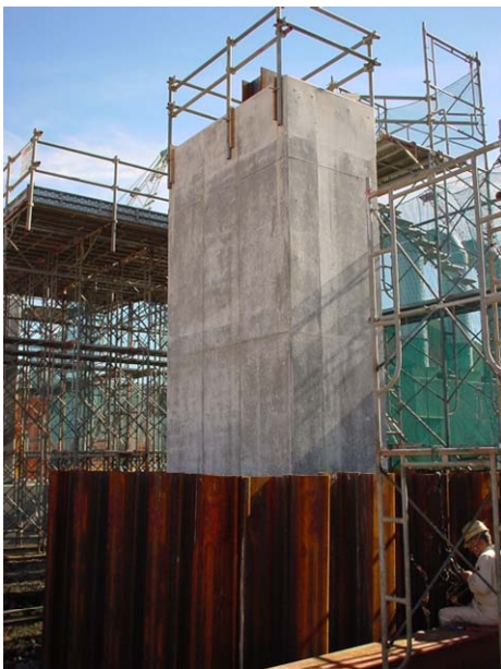
รูปที่ 1 การก่อสร้างฐานรากเข็มพืด (Sheet Pile Foundation)
