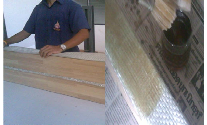
รูปที่ 4 การเสริมกำลังคานไม้ประกอบ
