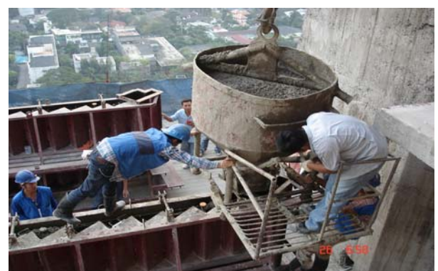
รูปที่ 3 กิจกรรมการเทคอนกรีต
