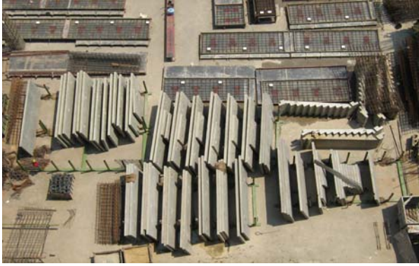
รูปที่ 4 การกองเก็บชิ้นงานคอนกรีตหล่อสำเร็จ
