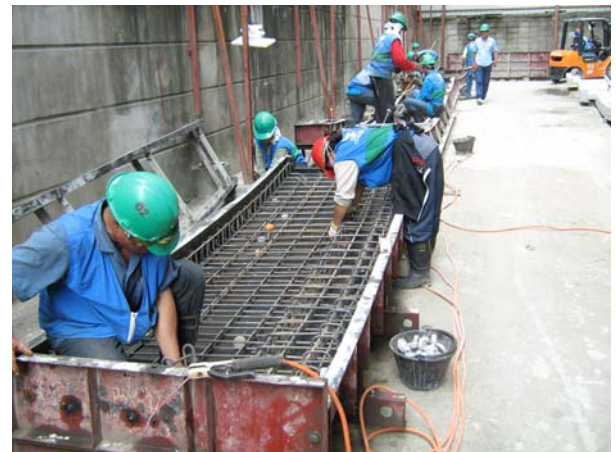
รูปที่ 2 กิจกรรมการใส่เหล็กเสริมลงแบบหล่อ
