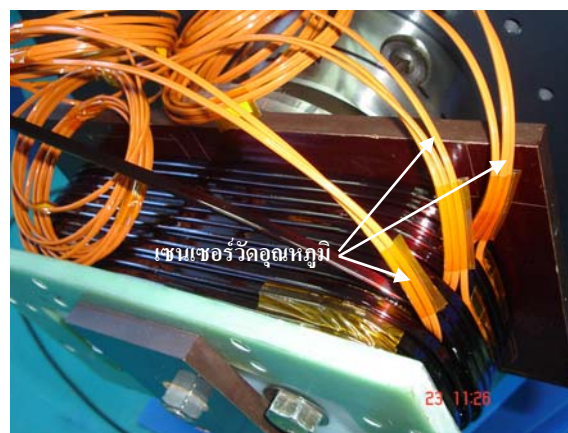
รูปที่ 9 การพันขดลวดแม่เหล็กและการติดตั้งเซนเซอร์วัดอุณหภูมิ
