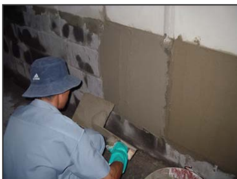
รูปที่ 3 การฉาบปูนบนผนังอิฐบล็อก (เอื้อเฟื้อภาพโดย บริษัท ทีพีโอโพลีน จำกัด (มหาชน))
