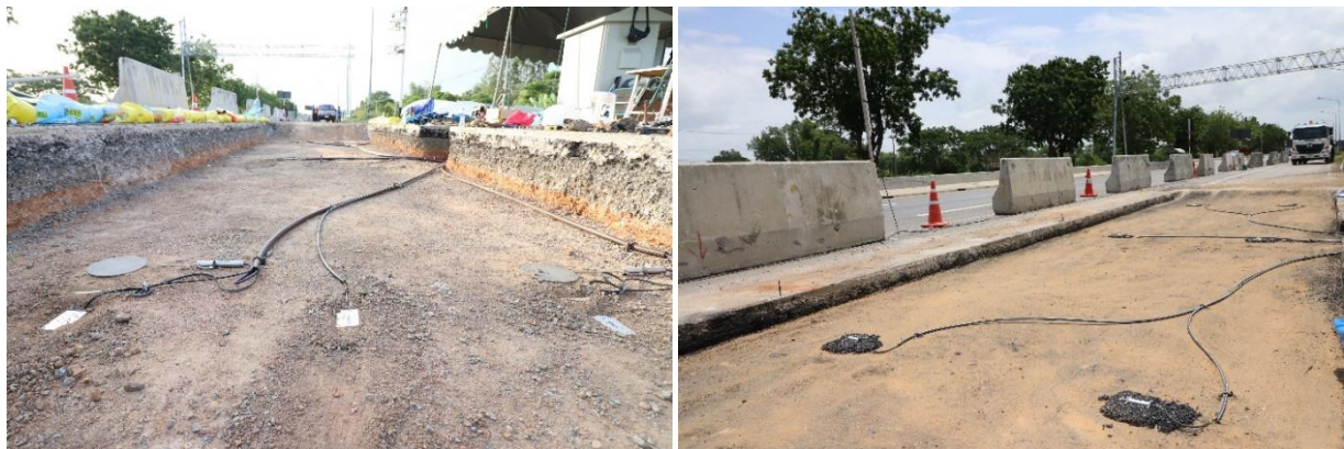
รูปที่ 3 ตัวอย่างอุปกรณ์ตรวจวัดที่ติดตั้งในแปลงทดสอบ
