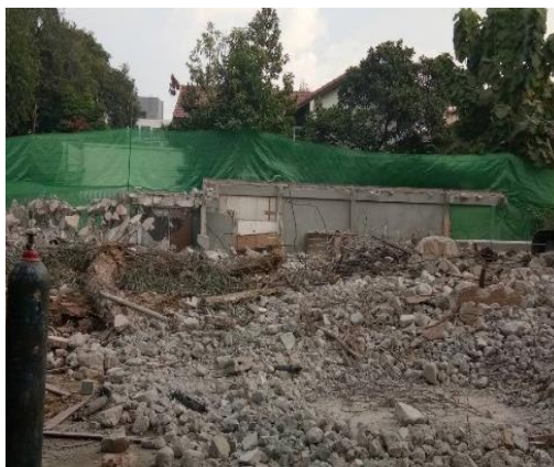
รูปที่ 3 ชากคอนกรีตเก่า
