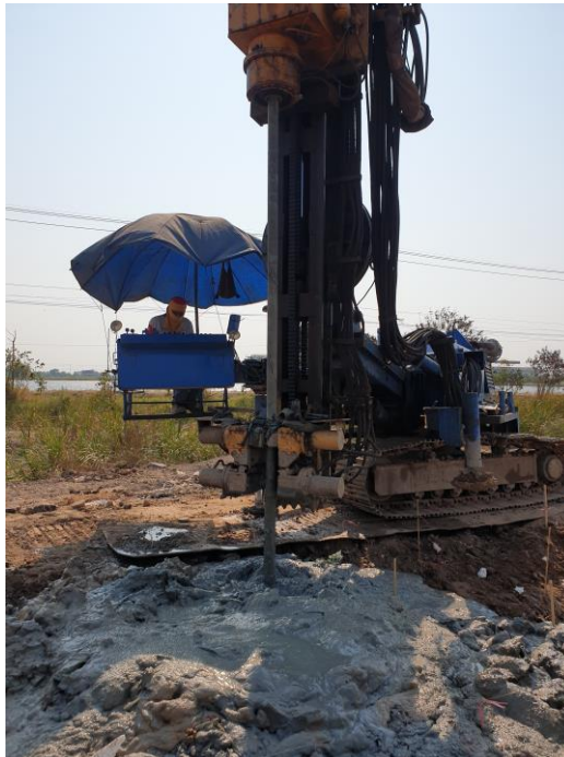
รูปที่ 2 ดินสเปกซ์ของโครงการก่อสร้างปรับปรุงถนนเลียบริมคลองระบายน้ำสุวรรณภูมิ
