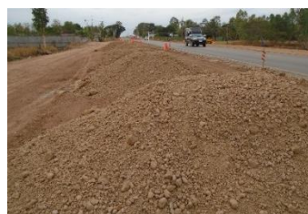
รูปที่ 2 ลูกรังรองพื้นทาง
