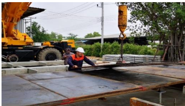
(ค) เคลื่อนย้ายแผ่นเหล็กโดยใช้ Magnetic lifters
