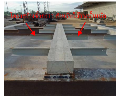
(ค) ภาพคานทดสอบหลังเทคอนกรีต
