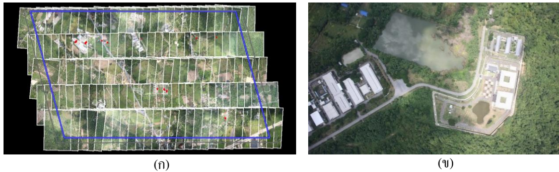
รูปที่ 3 (ก) ชุดข้อมูลภาพถ่ายทางอากาศในขอบเขตพื้นที่ศึกษา (ข) ตัวอย่างภาพถ่ายทางอากาศที่ถ่ายจากกล้อง Cannon EOS 5DSR สำหรับชุดข้อมูลทั้ง 3.1 และ 3.2 ทางกรมแผนที่ทหารได้ดำเนินการสำรวจไว้เมื่อวันที่ 7 ตุลาคม พ.ศ. 2562
