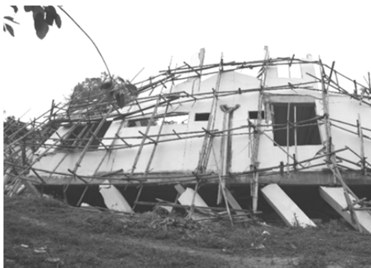
(ก) อาคารพักอาศัย หมู่บ้านห้วยส้านยาว
