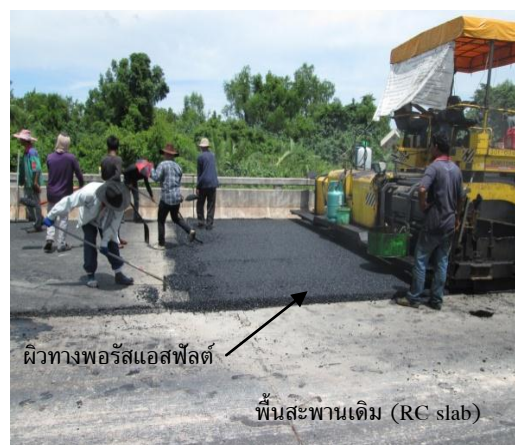
(ก) การก่อสร้างผิวทางพอร์สแอสฟัลต์
