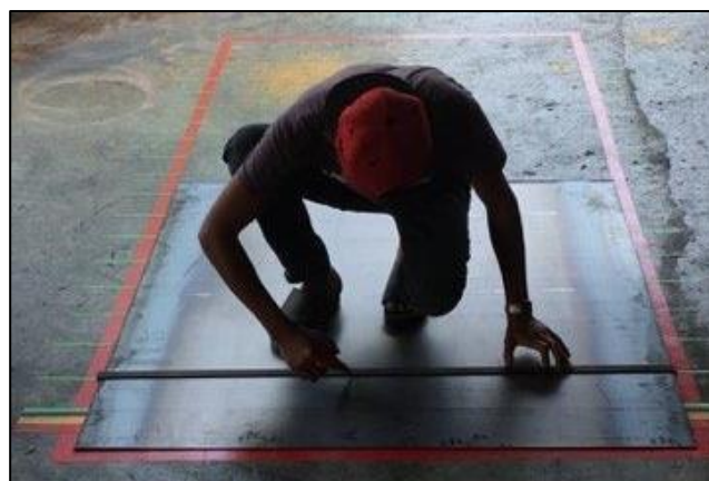
รูปที่ 11 การตีเส้นขอบข้อตามสีแถบสีที่กำหนด
