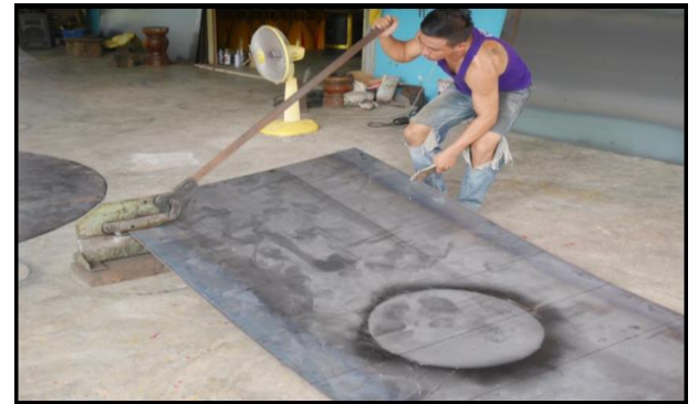
รูปที่ 8 การตัดแผ่นเหล็กขอบช่อง
