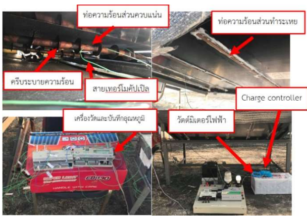
รูปที่ 8 การติดตั้งท่อความร้อน อุปกรณ์และเครื่องมือในการทดสอบ
