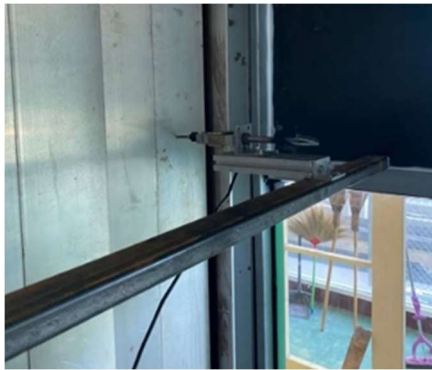
รูปที่ 12 การติดตั้งโหลดเซลล์ ชนิด S-type บริเวณกลางใบบานเกล็ดสำหรับทดสอบการต้านแรงลมชุดผนังบานเกล็ดบานเกล็ด
