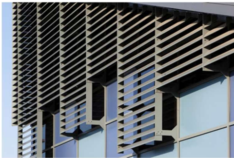
รูปที่ 2 ผนังบานเกล็ดอลูมิเนียมแบบ Fixed Type Louver (ที่มา: http://thai.aluminumcladdingpanel.com )
