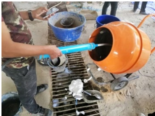
รูปที่ 1 การฉีดโฟมเหลวลงในซีเมนต์มอร์ต้า
