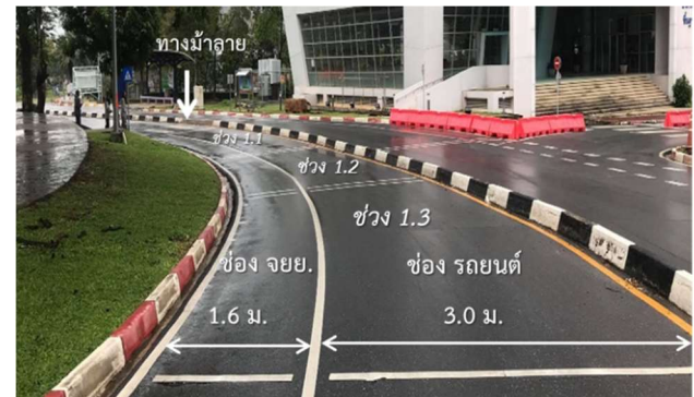
ก) ก่อนติดตั้งเส้นซิกแซก
