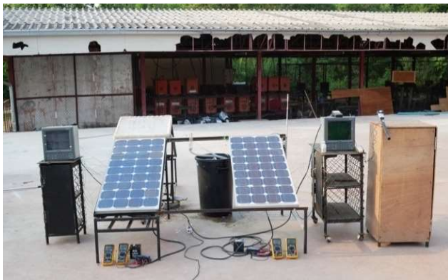
รูปที่ 7 การติดตั้งการทดลองแผง FTPV
