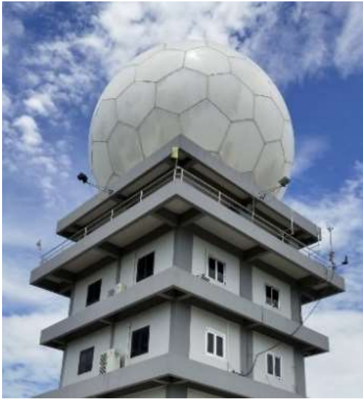
รูปที่ 1 ภาพสถานีเรดาร์ตาคาลิชนิด Dual polarization แบบ S-band
