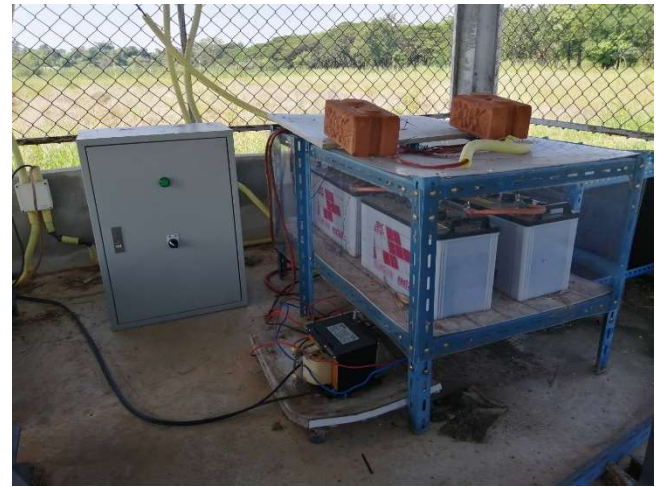
รูปที่ 18 ระบบการตามจุดกำลังสูงสุดของแผงเซลล์แสงอาทิตย์ขนาด 2,400 W ณ ฟาร์มมหาวิทยาลัย
