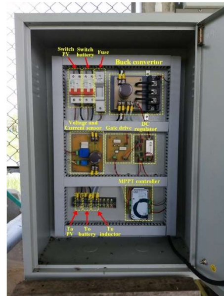
รูปที่ 18 ระบบการตามจุดกำลังสูงสุดของแผงเซลล์แสงอาทิตย์ขนาด 2,400 W ณ ฟาร์มมหาวิทยาลัย
