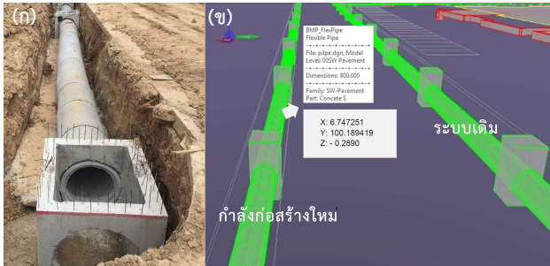
รูปที่ 8 ตัวอย่างเปรียบเทียบรูปก่อสร้างจริง (ก) และแบบจำลองสารสนเทศวัตถุได้ดิน (ข) โครงการกรณีศึกษา
