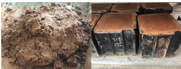
รูปที่ 3 เทส่วนผสมดินซีเมนต์ลงในแบบหล่อ
