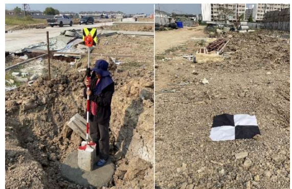
รูปที่ 3 แสดงการรังวัดตำแหน่งเสาเข็มและจุดควบคุมภาคพื้นดิน
