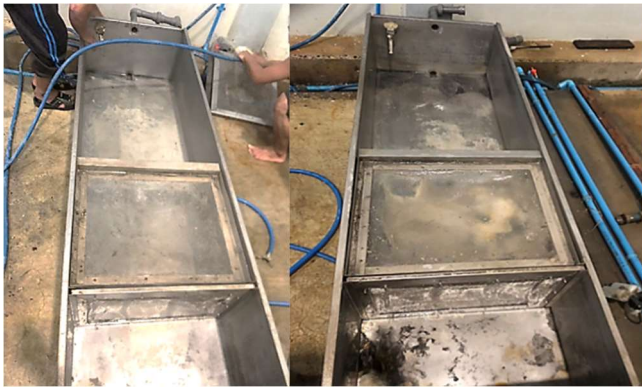
รูปที่ 14 ทำความสะอาดถังเก็บน้ำไหลเวียน
