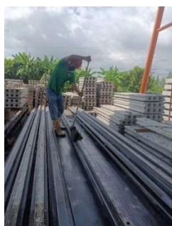
(ก) แสดงรูปการทำงานทำความสะอาดแม่แบบแบบเดิม
