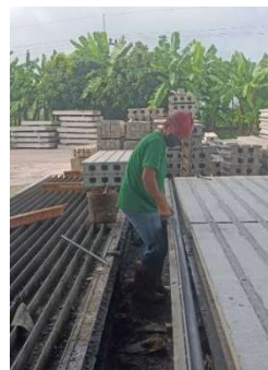
(ก) แสดงรูปการนำฝาข้างออกแบบเดิม
