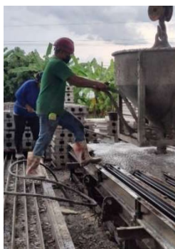
(ก) แสดงรูปการเทปูนคอนกรีตลงในแม่แบบแบบเดิม
