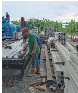
รูปที่ 12 ท่าทางที่ 12 เกลี่ยปูนคอนกรีตลงในแม่แบบ
