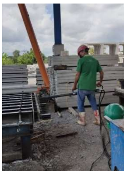
(ก) แสดงรูปการถือเครื่องดึงเหล็ก เพื่อให้เหล็กตึงแบบเดิม
