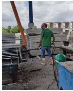
รูปที่ 10 ท่าทางที่ 10 ใช้เครื่องดึงเหล็กเพื่อให้ออกมาจากรู
