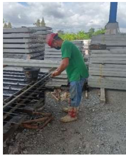
รูปที่ 9 ท่าทางที่ 9 ใช้สิ่วเกี่ยวเหล็ก
