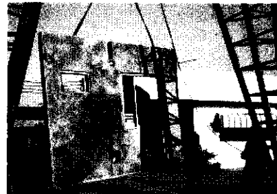
รูปที่ 4 การยกขนย้ายชิ้นส่วนผนังคอนกรีตหลังการถอดแบบ
