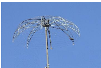
รูปที่ 11 แท่งป้องกันฟ้าผ่าแบบกระจายประจุ
