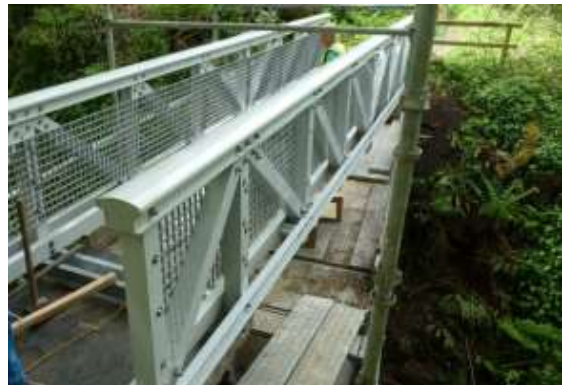
รูปที่ 2 สะพานที่ประกอบขึ้นจากชิ้นส่วน FRP
