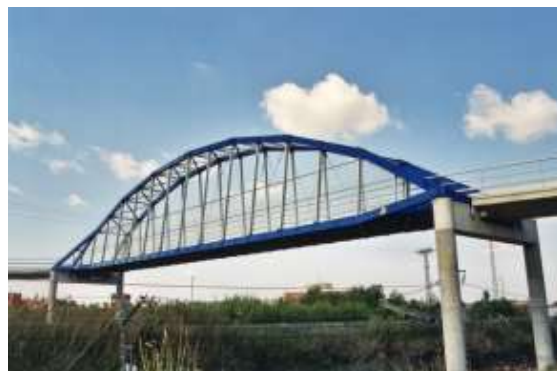
รูปที่ 1 สะพานข้ามทางรถไฟที่สร้างจากวัสดุ FRP (FRP Lleida Pedestrian Bridge 2001)
