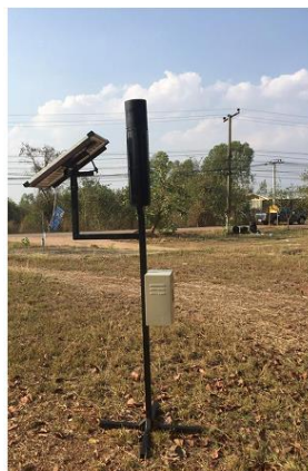
(ข) โครงสร้างจริง
